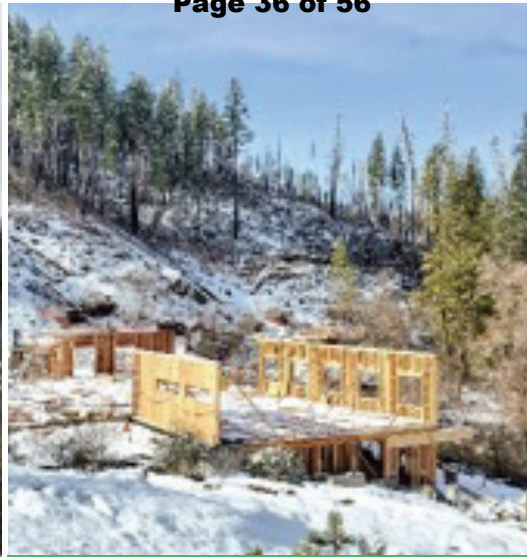
Berkeley Tuolumne Camp renovation
