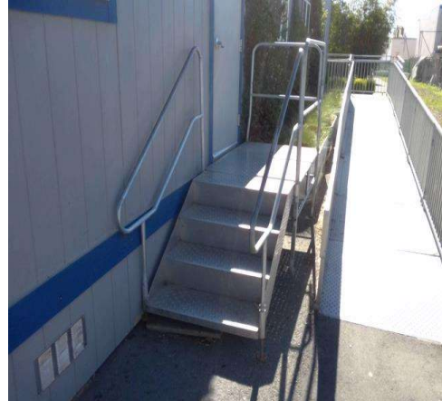
Stairway , Risers Striping : No Riser Striping
