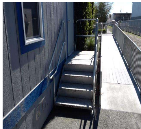
Stairway , Risers Striping : No Riser Striping
